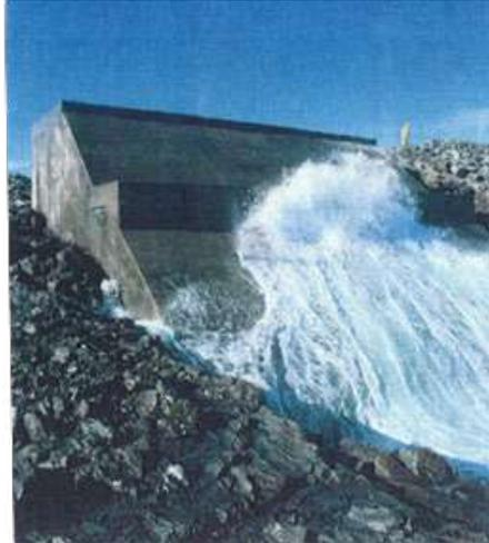
Figura 31. Imagen del Generador de Olas Oceánicas de la Isla de Islay
