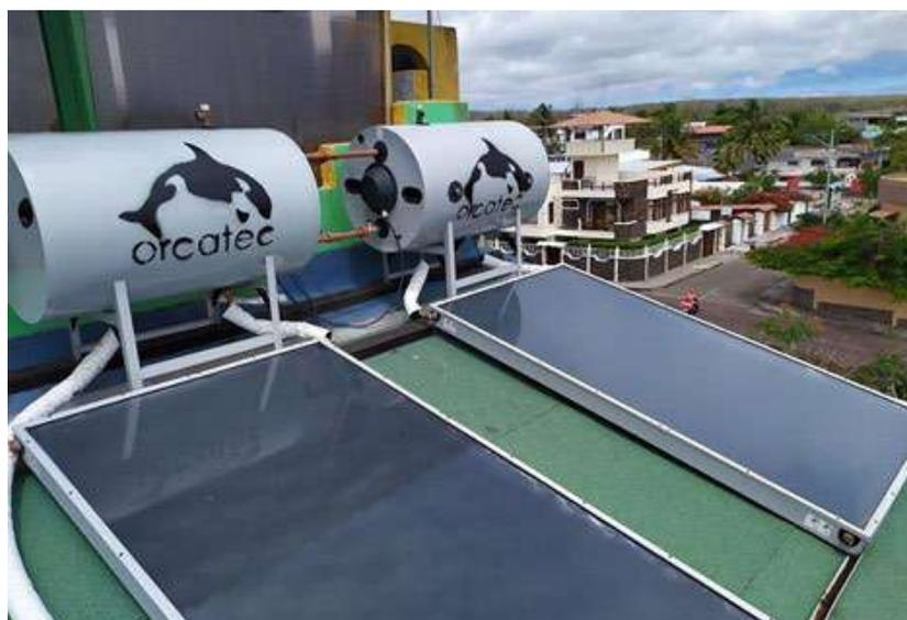
Figura 16. Imagen de dos sistemas solares térmicos Orcatec para el suministro de agua caliente. (Cortesía: Orcatec.ec)
